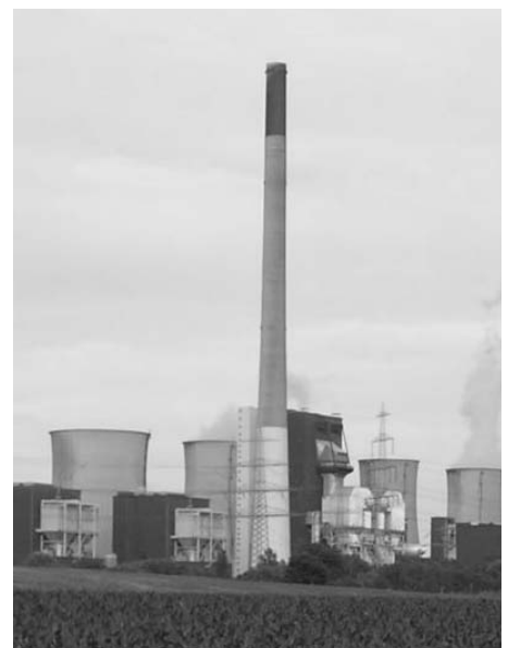
▲ Foto: Steinkohlekraftwerk Gelsenkirchen-Scholven
