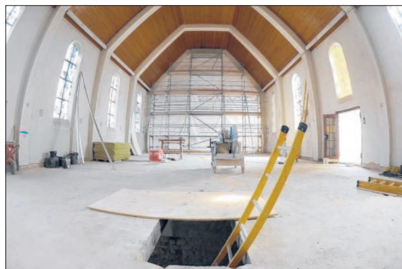
Umbau: Vor dem Altarbereich wurde eine Schutzwand gezogen, um bei den Abrissarbeiten den Raum zu schützen.
